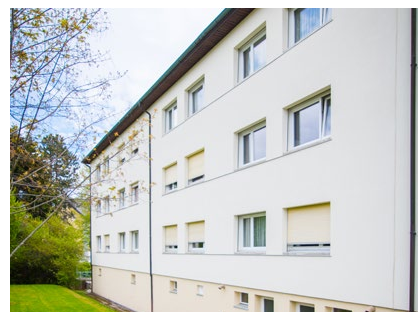
Derrière-La-Ville 2 – 4 – 6 1055 Froideville Année de construction 1970 Nombre de logements 24 Valeur assurée 4 720 552
