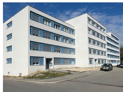
Montolieu 147 – 149 1010 Lausanne Année de construction 1970 Nombre de logements 27 Valeur assurée 6 270 840
