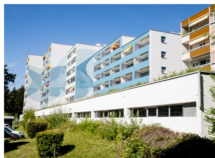
Montolieu 151 – 159 ● 1010 Lausanne Année de construction 1970 Nombre de logements 85 Valeur assurée 23 191 720
