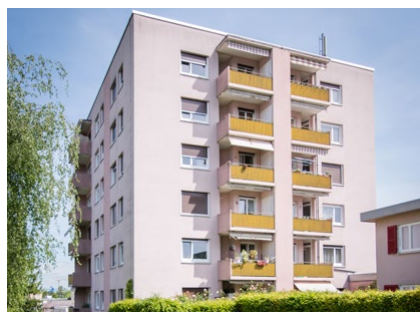
Cassinette 5 – 7 – 9 1018 Lausanne Année de construction 1957 Nombre de logements 32 Valeur assurée 3 565 800
