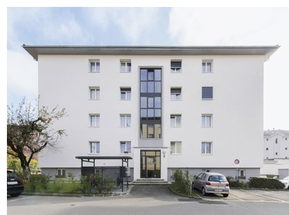
Taudaz 9 ● ● 1028 Préverenges Année de construction 1960 Nombre de logements 13 Valeur assurée 2 849 900
