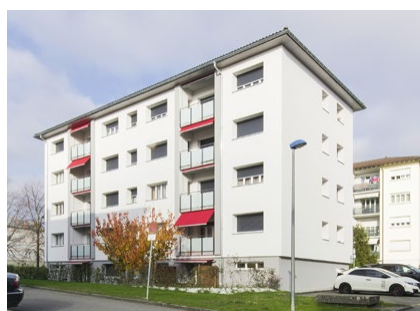
Taudaz 4 ● ● 1028 Préverenges Année de construction 1964 Nombre de logements 14 Valeur assurée 2 863 810
