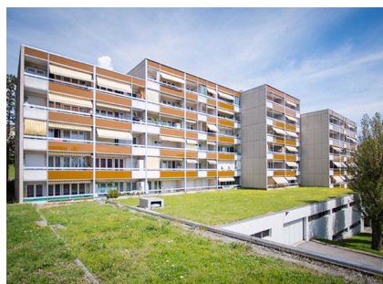
Montolieu 135 – 145 1010 Lausanne Année de construction 1972 Nombre de logements 69 Valeur assurée 19 337 620
